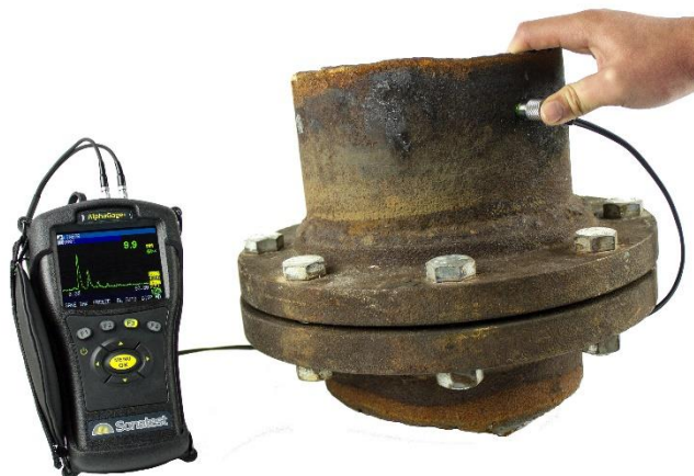
verze Corrosion – měření koroze
